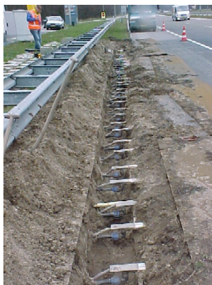
Figuur 3.3 Aanleg meetopstelling
