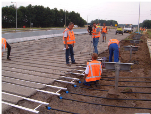
Figuur 3.1 Aanleg proefwegdek
