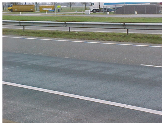
Figuur 3.4 Aanzicht proefwegdek
